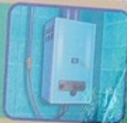
Газовая колонка и автономный газовый котел для подогрева воды
